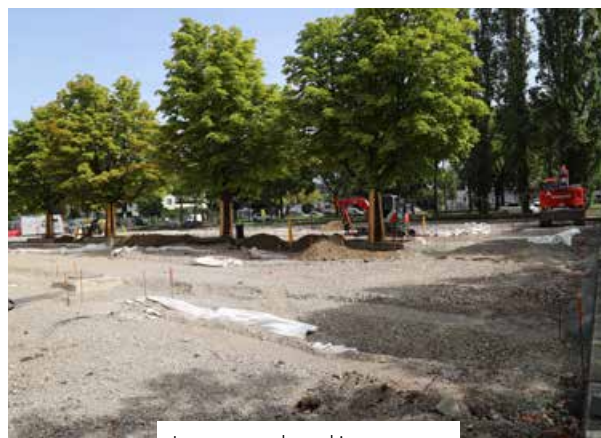
Les travaux du parking en cours
