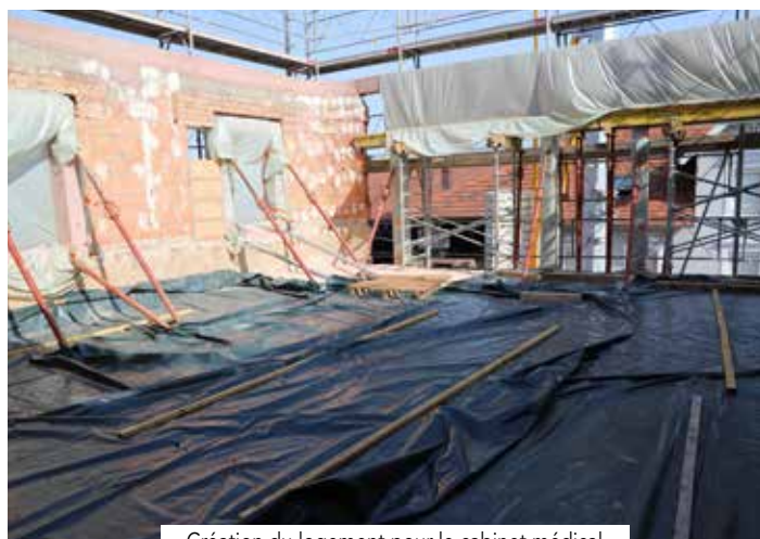
Création du logement pour le cabinet médical
