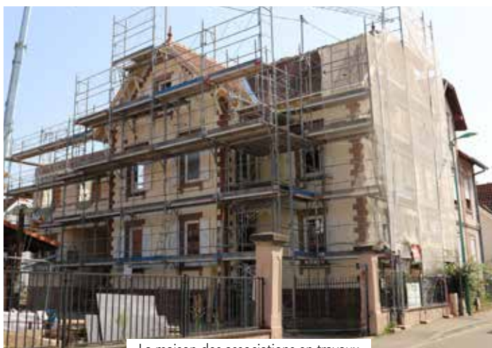
La maison des associations en travaux
