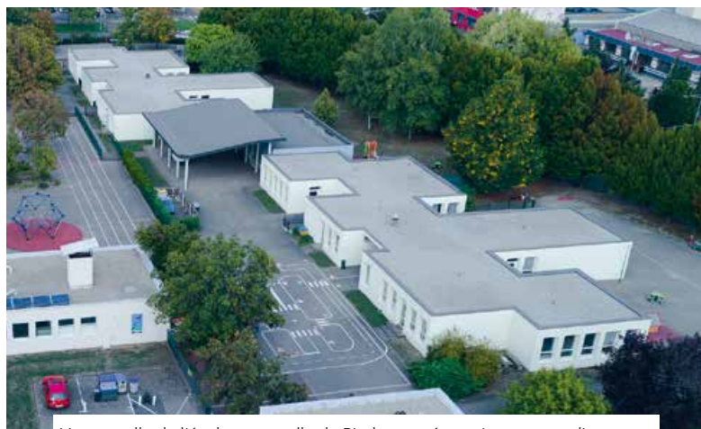
Vue actuelle de l'école maternelle du Ried avant rénovation et agrandissement.
