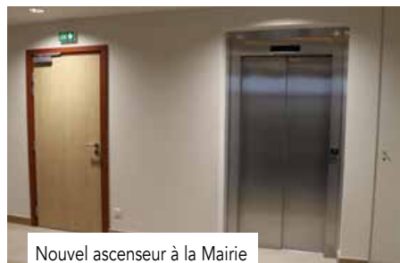
Nouvel ascenseur à la Mairie
