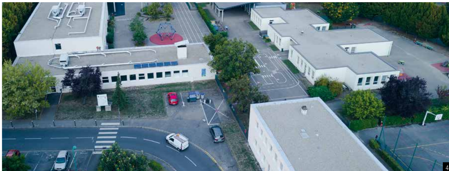
Premiers panneaux photovoltaïques installés sur le groupe scolaire Bouchesèche
