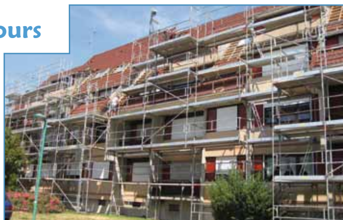
Les travaux ont démarré en juillet (Photo DEWH)
