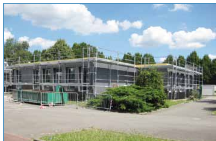
Les bâtiments de l'école maternelle du Ried étaient encerclés d'échafaudages cet été (Photo DEWH)
