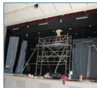
Toutes les rampes, à l'arrière de la scène, ont été remplacées (Photo DEWH)
